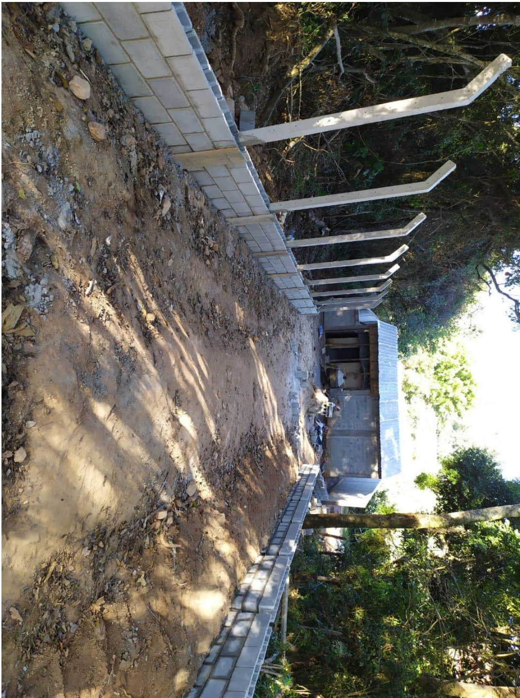
FIGURA 01 – FRENTE DA CAPTAÇÃO COM MURETAS PARA FIXAÇÃO DO ALAMBRADO.
